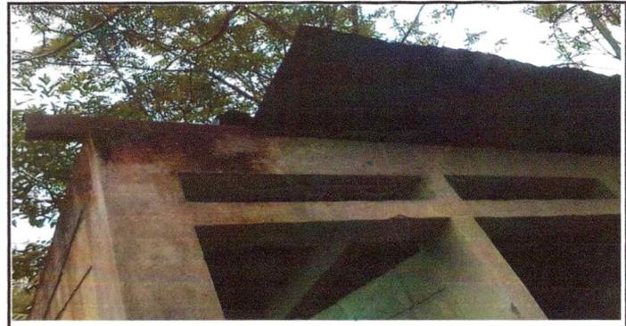
Foto 6: se observa el modulo de baño de niños, pared expuesta a la humedad.
