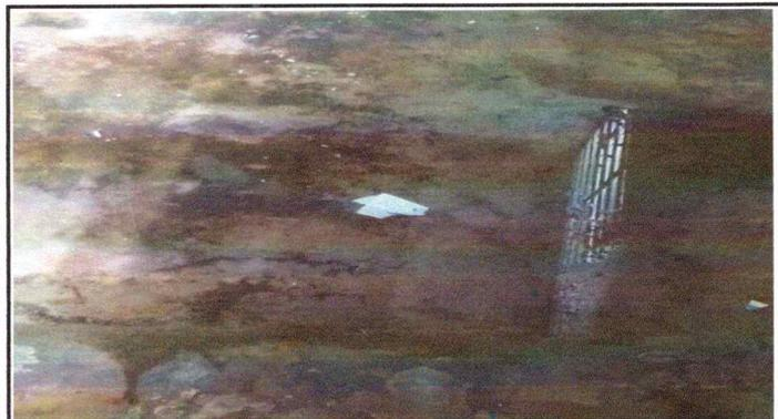
Foto 3: se observa el piso mojado cuando llueve, por que el agua se filtra en el techo en el modulo 1 y 2.
