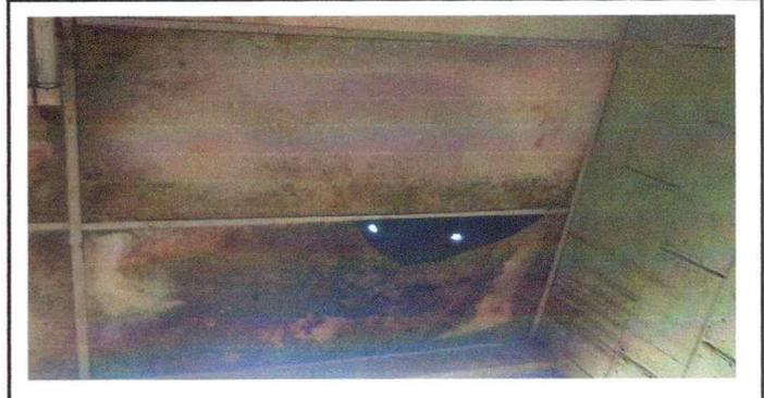
Foto 2: se observa el deterioro de la lamina en el modulo 1 y 2 , ahí donde se filtra el agua.
