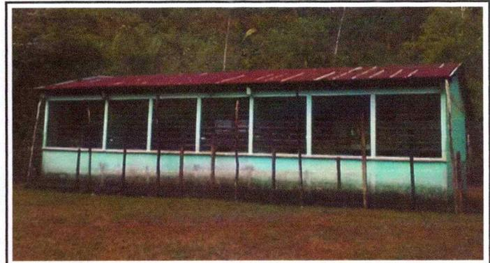
Foto 4: se observa el deterioro de las laminas en el modulo 1 y 2.
